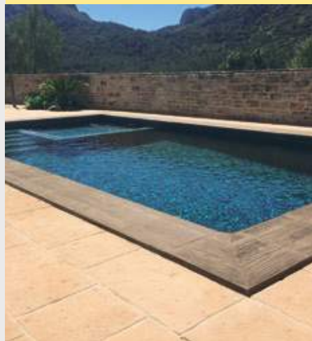
PAVIMENTOS Y REMATES DE PISCINA
