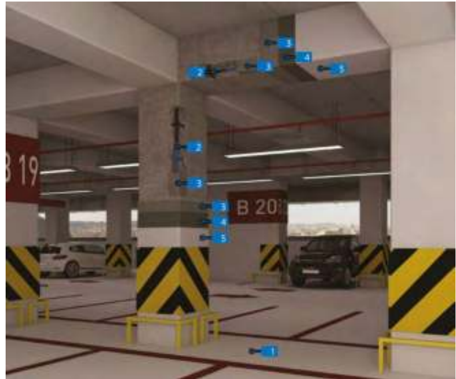
REHABILITACIÓN DE PÁRQUINES COMUNITARIOS CON SISTEMA DURADERO PARA LA PROTECCIÓN Y REPARACIÓN ESTRUCTURAL DE ELEMENTOS DE HORMIGÓN ARMADO CON ACABADO ELASTOMÉRICO
